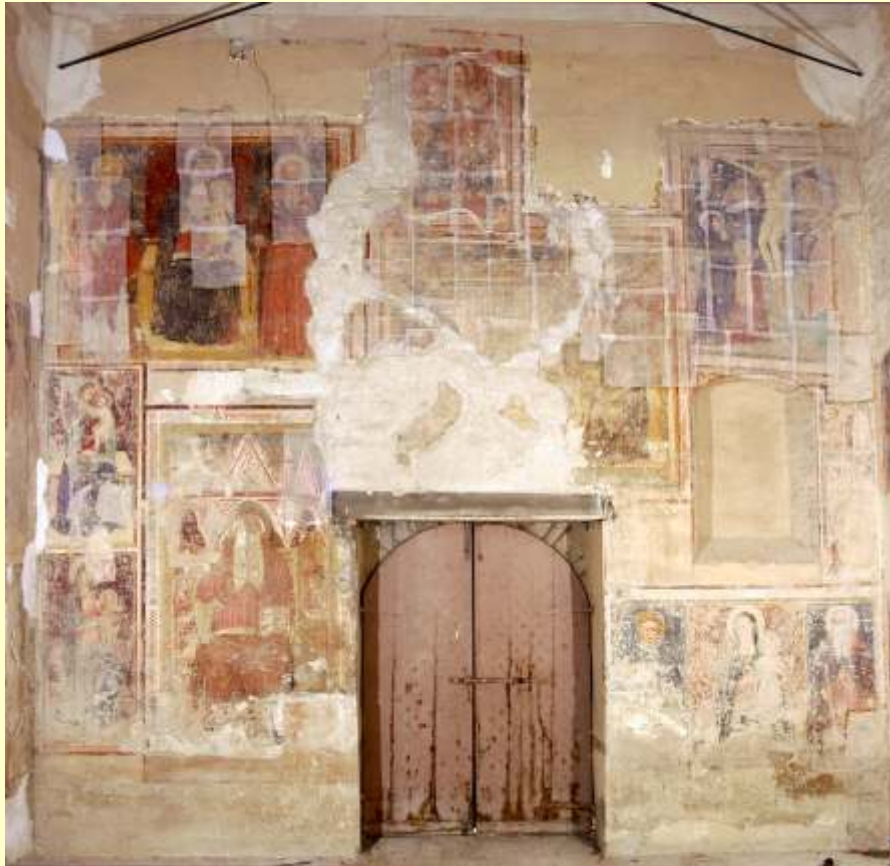
Ingresso occidentale (interno), Madonna della Villa, Sant'Egidio (Perugia)
