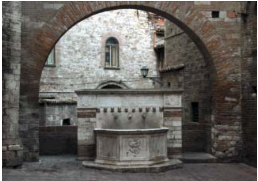
Fonte di via Maestà delle Volte - Fontana in stile medievale del 1928. Ubicata nello straordinario scenario coperto dalle volte che sostenevano il Palazzo del Podestà distrutto nell'incendio del 1534.
